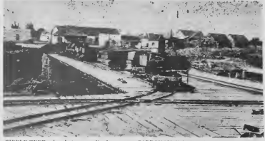
TERCER riel a worde instalá anteriormente pa acomoda carronan flat di 60 inch standard-gauge lastra door di locomotifinan di gauge-smal.
